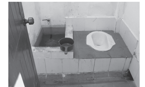
ラオス ナノイ村の小学校のトイレ
